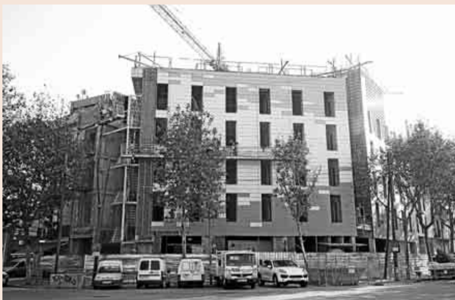
El albergue se llamará Twentytú y está en el número 22 de la calle Tànger, en el 22@ de Barcelona. /E. R.
